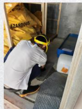
危废转移人员用吸酸棉处理泄漏
