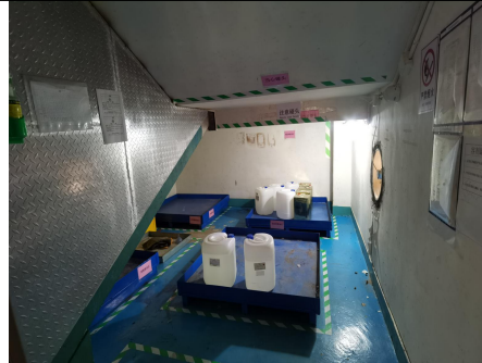
图 10 化学品仓库防泄漏栈板
